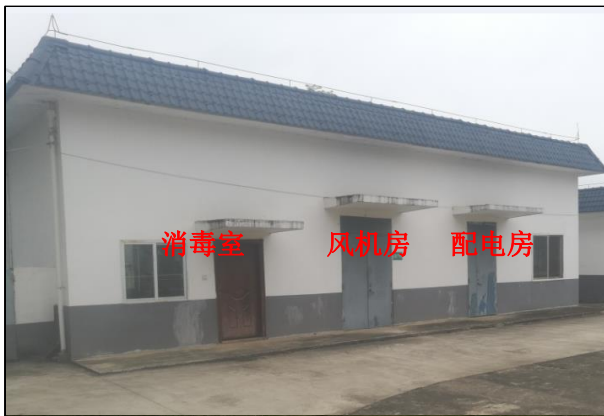
消毒室、风机房、配电房现状
