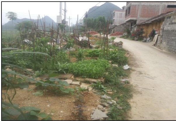
小学至污水厂段管网地表现状
