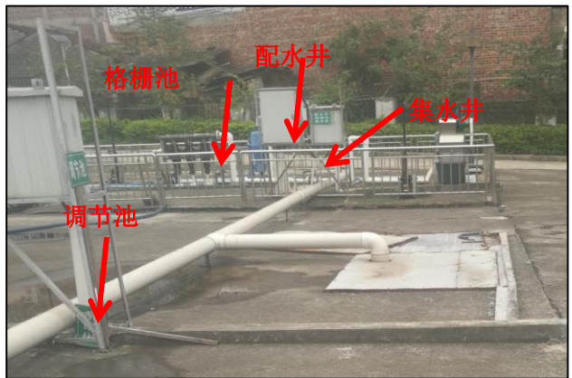
调节池、格栅池、集水井、配水井现状
