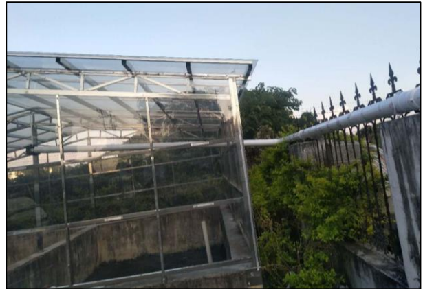
污泥干化池现状
