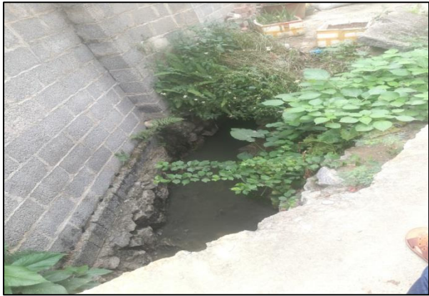
西北街污水截流口现状
