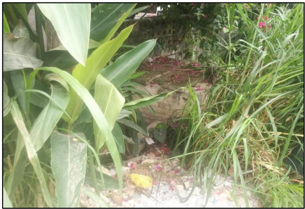
小学南面污水截流口现状
