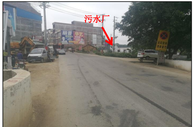
项目北面现状
