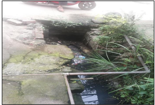
西北街污水截流口现状
