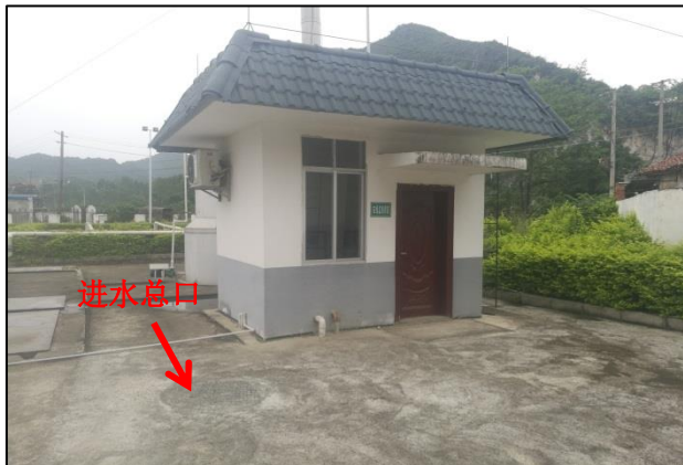
进水口现状及在线监测用房
