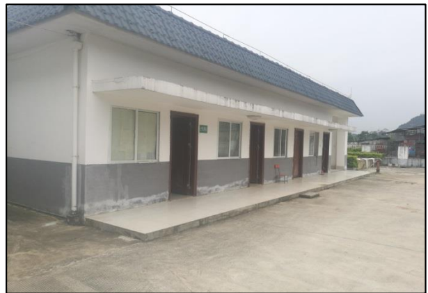
生产管理用房现状
