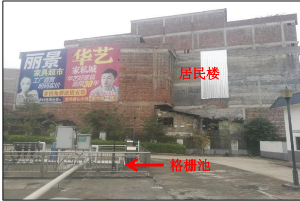
项目东面现状
